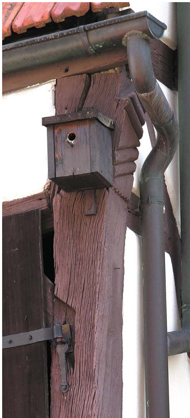
Eckständer mit verzierter Knagge an der Scheune Werfelgasse 12. Bild: RL
